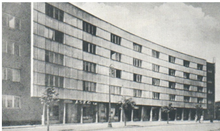
arch. J. Szanajca – Dom mieszkalny ZUS-u w Warszawie 1936 [ P. Trzeciak “Przygody architektury XX wieku” , foto str. 162 ]
