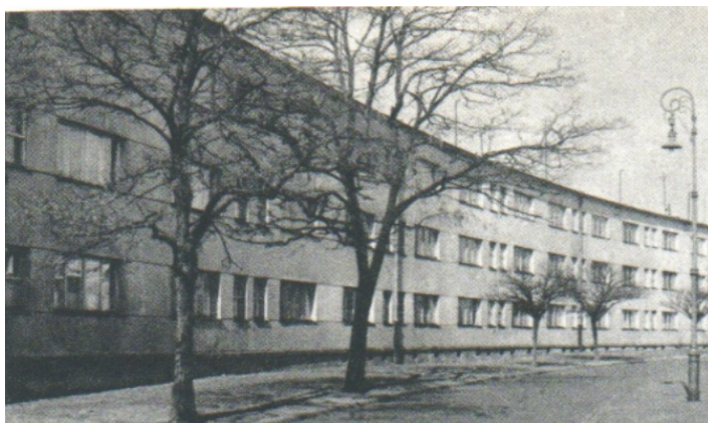
arch. arch. B.S. Brukalscy - domy mieszkalne VII Kolonii WSM na Żoliborzu 1930r. [ P. Trzeciak "Przygody architektury XX wieku" , foto str. 160 ]
